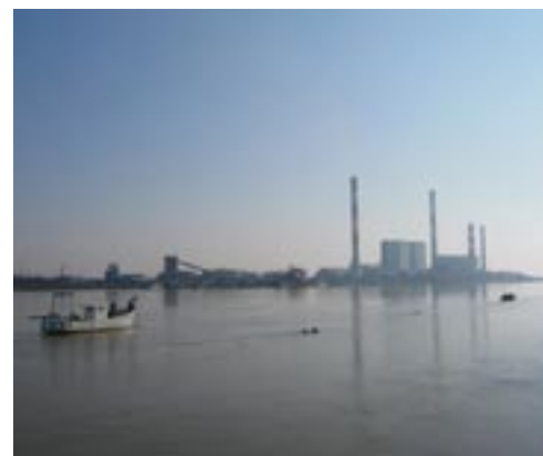
Le Centre de production thermique EDF vu de la rive sud
